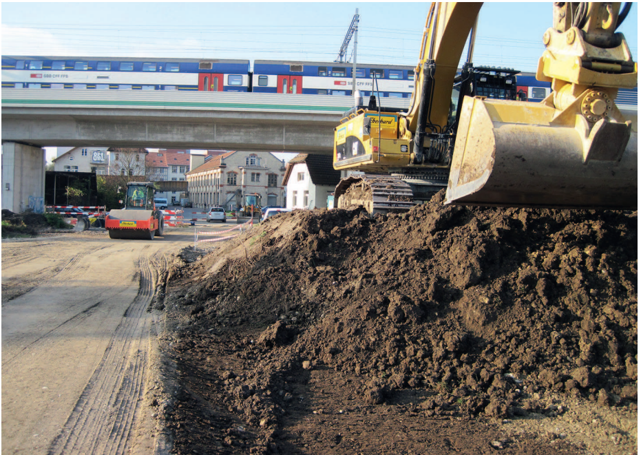
Am 31. Oktober 2013: die Bauarbeiten auf dem Baufeld E sind in vollem Gang. Blick in Richtung S-Bahnviadukt und auf das «Kernstück» des Zwicky-Areals.
